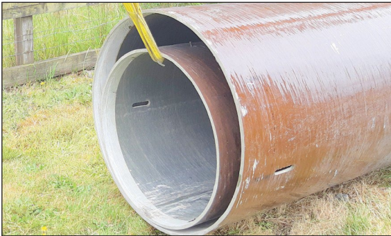
Figures 3a et 3b : Un camion-grue soulevant les modules vers le haut et vers l'extérieur pour les désempoîter et éviter les rayures
