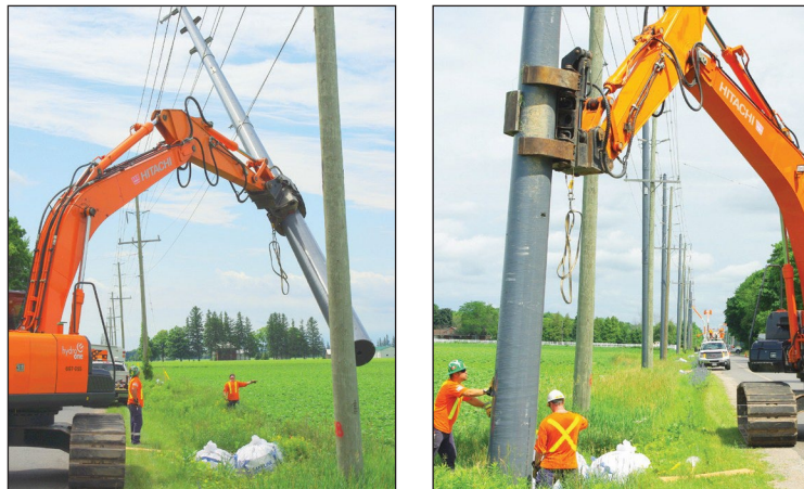
Figures 25a et 25b : Grappin installant un poteau à double circuit de 44 kV pendant une panne
