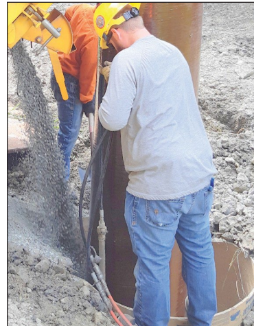
Figures 28a et 28b : Techniques de scellement et de remblai
