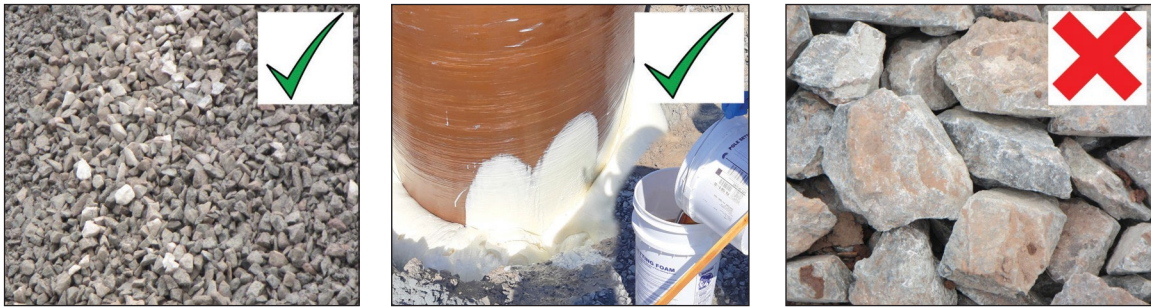
Figures 29a, 29b et 29c : Exemples d'options de remblayage acceptables et inacceptables
