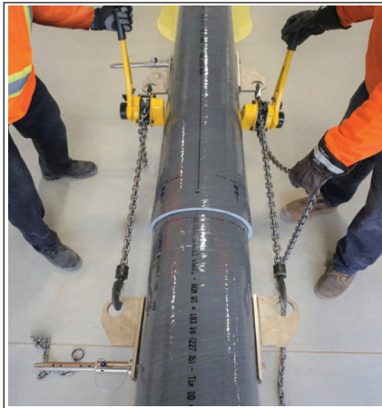
Figure 12 : Force d'assemblage égale appliquée des deux côtés
