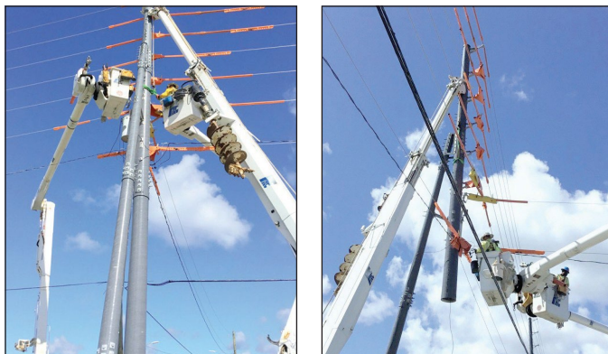
Figures 30a et 30b : Module de base remplacé à l'aide de techniques pour les lignes sous tension
