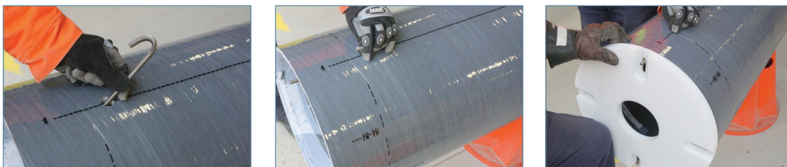
Figure 19a, 19b et 19c : Installation d'un boulon en J dans le trou prépercé et positionnement de la plaque de base
