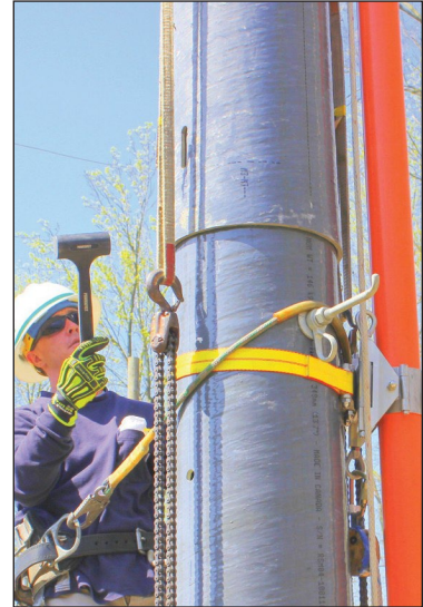
Figures 31b et 31c : Mât de levage – méthode d'assemblage du poteau vertical
