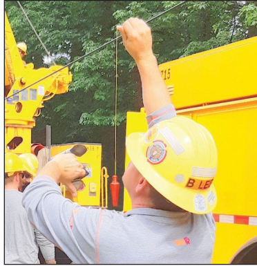
Figure 26 : Utilisation d'un fil à plomb pour aligner verticalement un poteau
