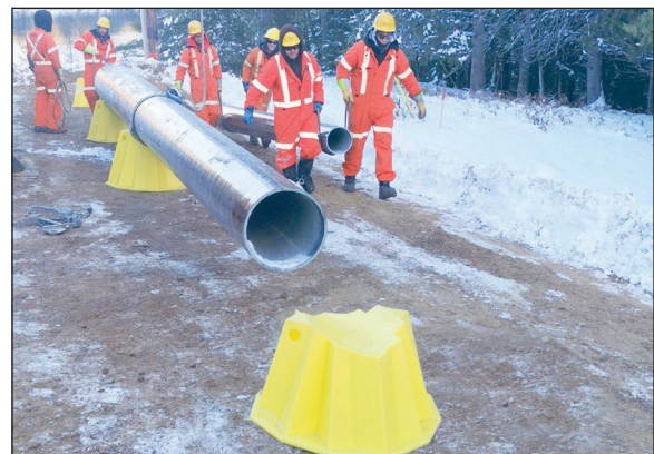
Figure 5b : Un poteau RS sur des supports pour poteaux
