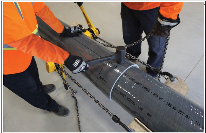
Figure 13 : Réduction de la friction statique à l'aide d'un maillet sans rebond
