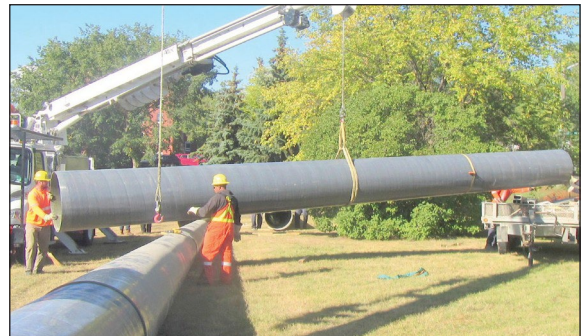
Figures 4a et 4b : Petits modules non emboîtés disposés pour l'assemblage
