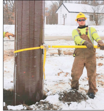
Figure 27 : Les poteaux RS peuvent être tournés facilement à l'aide d'un levier à poteau
