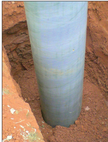
Figures 28a et 28b : Techniques de scellement et de remblai
