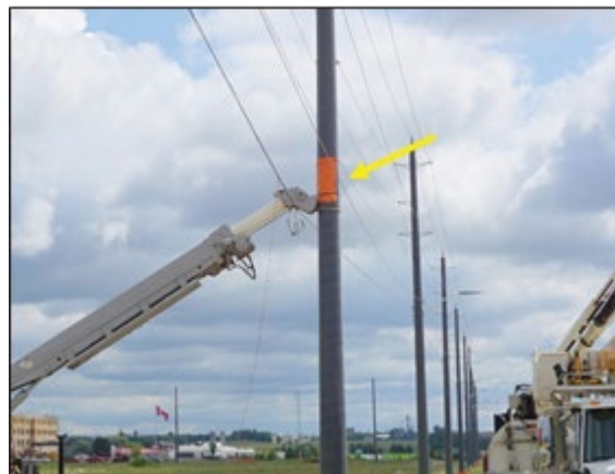
Figure 23 : Tapis en caoutchouc temporaire pour protéger la surface du poteau de la flèche
