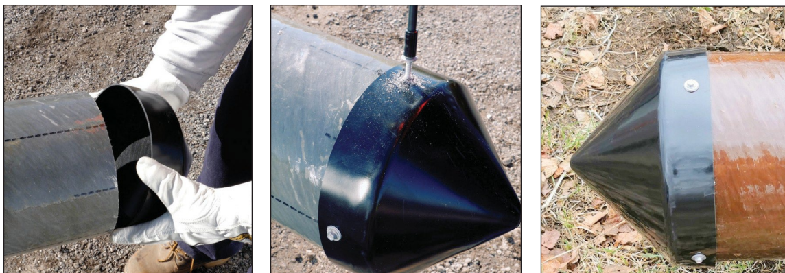
Figures 21a, 21b et 21c : Positionnement et installation du capuchon supérieur
