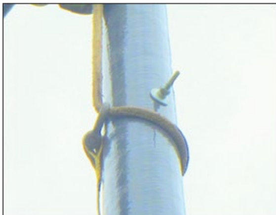
Figure 22 : Boulon temporaire pour empêcher le glissement de l'élingue
