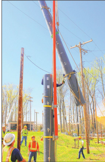
Figures 31b et 31c : Mât de levage – méthode d'assemblage du poteau vertical
