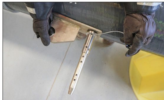
Figures 10a et 10b : Installation du collier de retenue et recherche du jeu de trous adapté pour un ajustement serré
