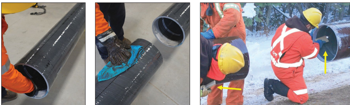
Figures 7a, 7b et 7c : Essuyage de la surface intérieure du module supérieur et de la surface extérieure du module inférieur
