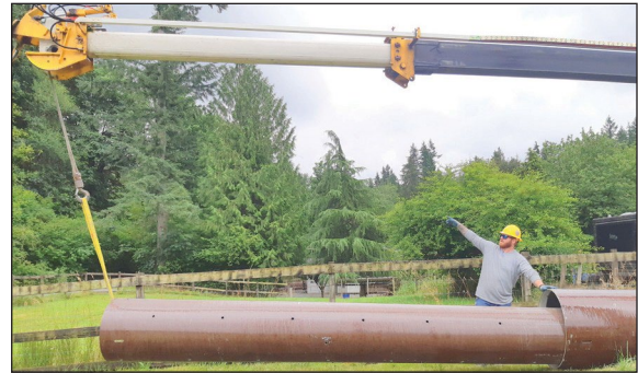
Figures 3a et 3b : Un camion-grue soulevant les modules vers le haut et vers l'extérieur pour les désempoîter et éviter les rayures
